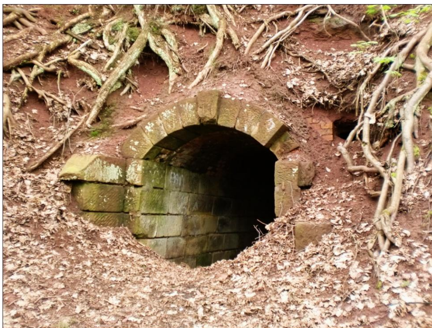
Obr. 15 Portál bývalé štoly v Udánkách (foto: L. Navrátil 2013)
