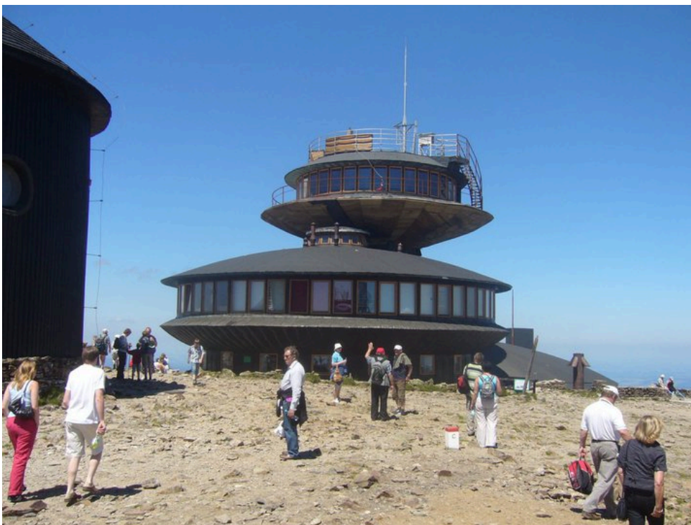
Obrázek 3 – Opravená Polská bouda v roce 2010
