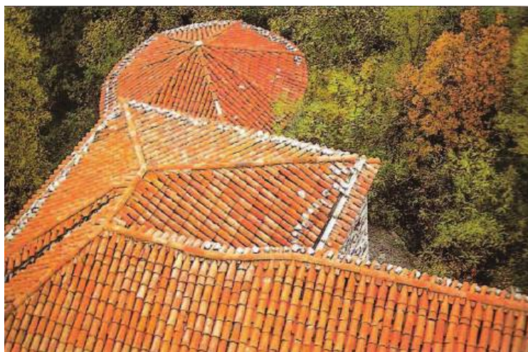
Obr. 32 Kameny zatěžující střechu (Perko, 2001)
