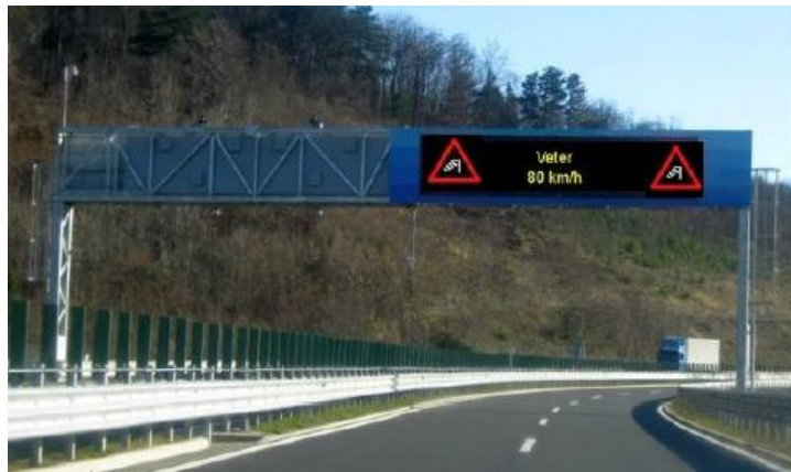
Obr. 35 Informační tabule signalizující sílu větru na dálnici (Pirc, Korošec, 2010)
