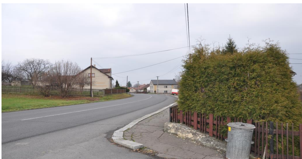
Obr. 2: Bývalá hráz (nyní silnice) zaniklého rybníka u obce Hladké Životice (listopad 2012)
