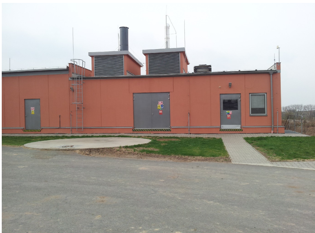
Obr. 22 Bioplynová stanice Mutěnice (zdroj: vlastní fotografie)
