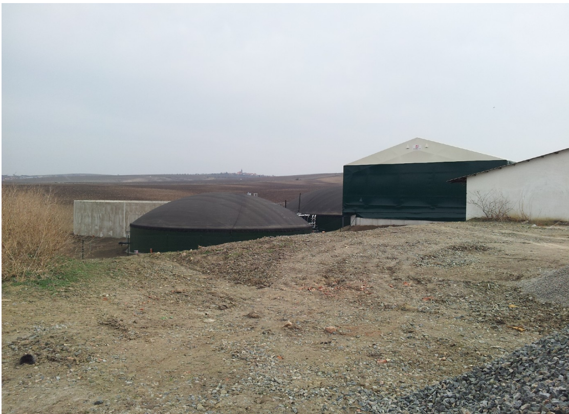
Obr.24 Bioplynová stanice Bořetice ( ve výstavbě ) ( zdroj: vlastní fotografie )
