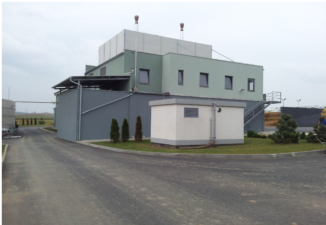
Obr. 21 Bioplynová stanice Švábenice (zdroj: vlastní fotografie)
