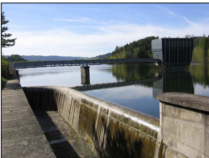
Obr. 6: Věžový objekt vodního díla Letovice (foto: H. Václavíková, 2012)
