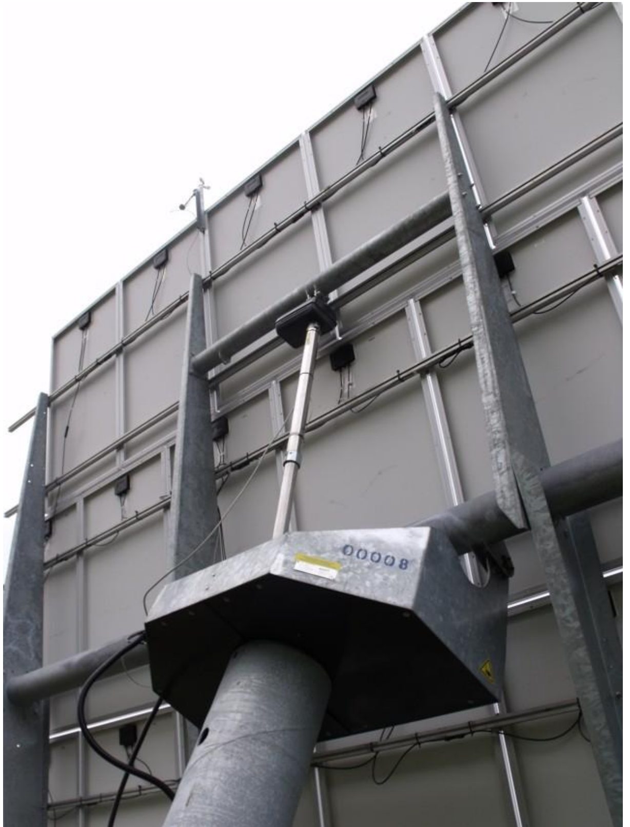
Příloha 13: Hydraulická konstrukce, FVE Králíky, kú Králíky. Adam Prousek (04/2012).
