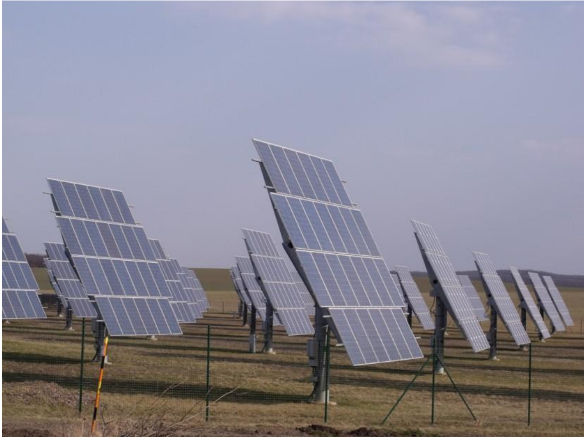
Příloha 16: Polykrystalické panely na otočných stojanech FVE Králíky, Adam Prousek (03/2012).
