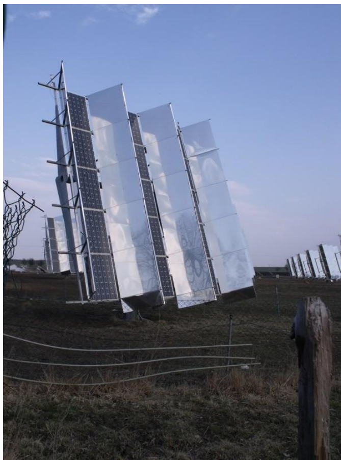
Příloha 7: Zrcadla soustředující sluneční záření na panely. FVE Myštěves, kú Myštěves (04/2012).
