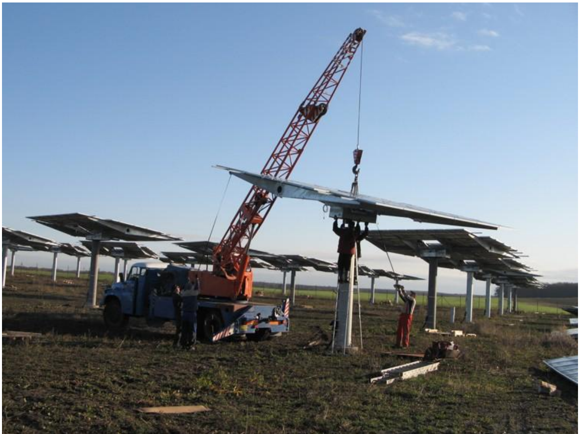
Příloha 17: Výstavba FVE Králíky, archiv AMOS energo, a.s.
