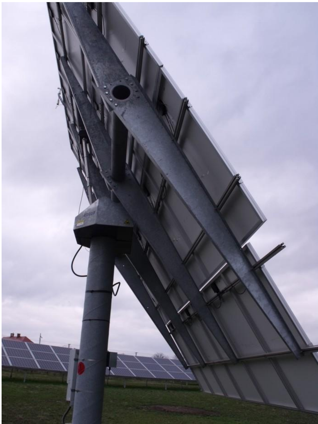
Příloha 14: Otočný stojan polykrystalických panelů FVE Králíky, kú Králíky. Adam Prousek (04/2012).
