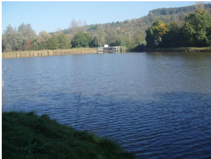
Příloha 11: Míkovická přehrada, Uherské Hradiště (Příbyl 2012)
