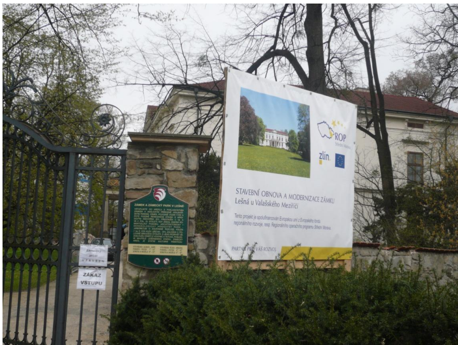
Obr. 15: Zámek v době rekonstrukce v obci Lešná
