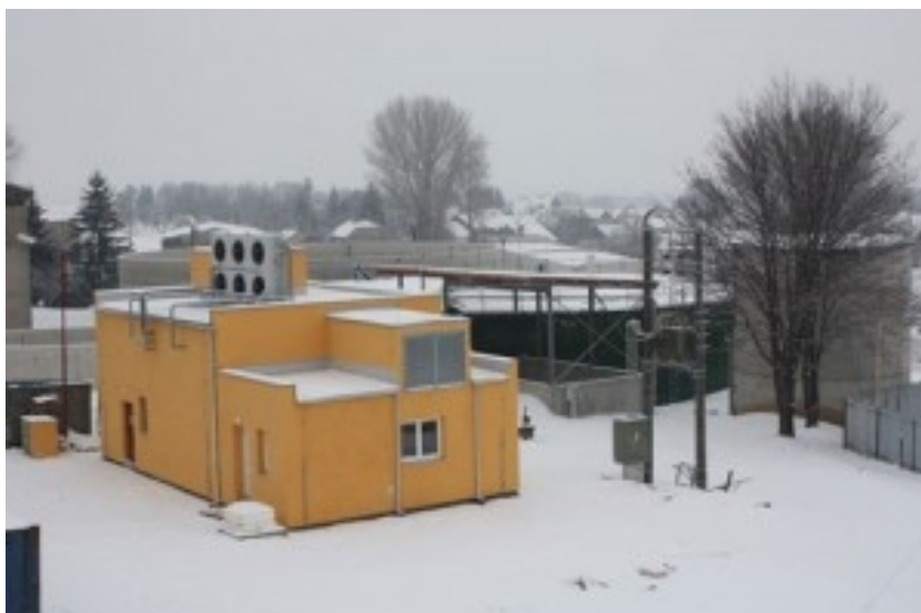
Obr. 3: Bioplynová stanice v obci Tištín (CZ Biom [online], 2009)
