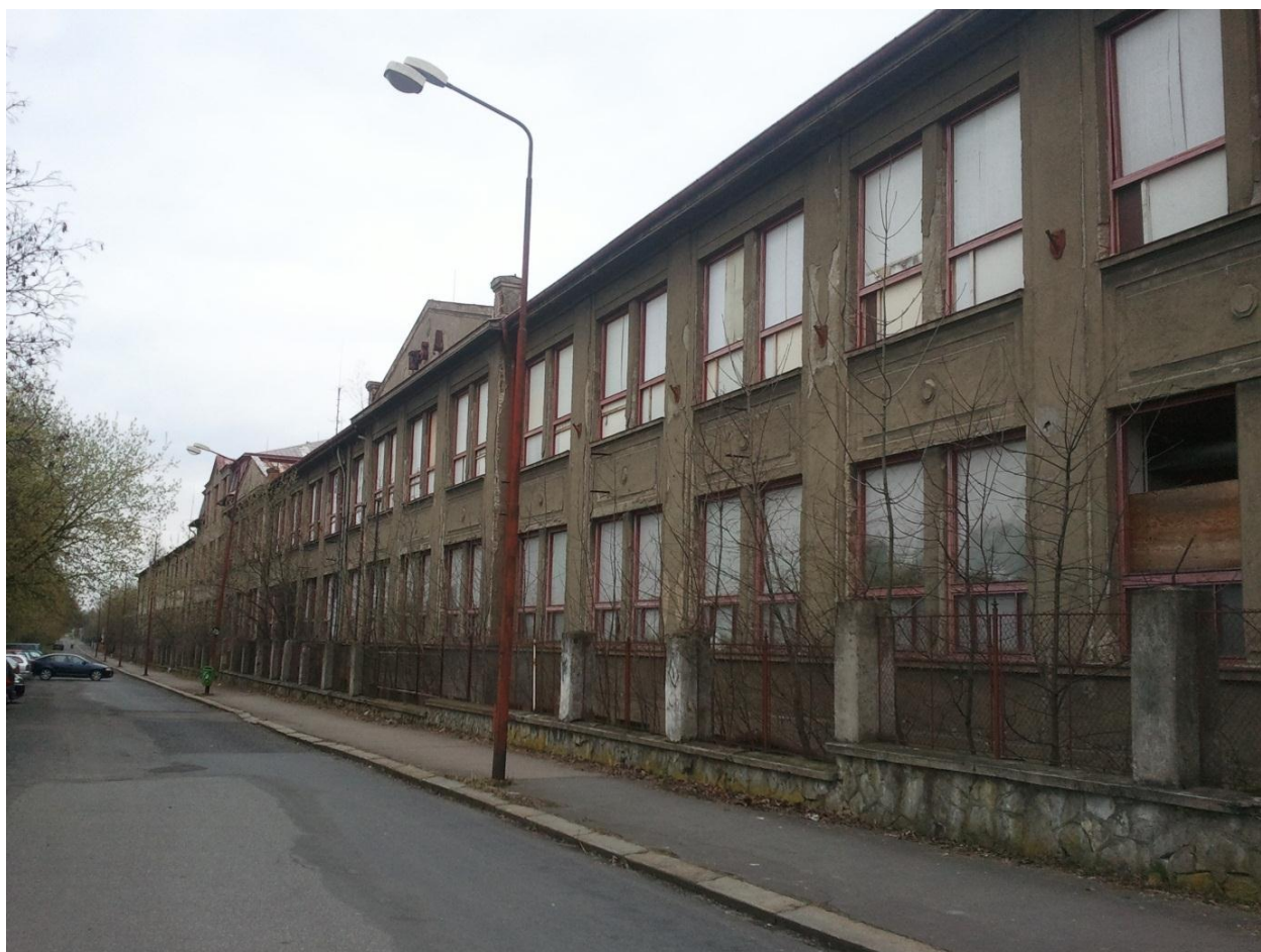
Obr. č. 7: budova bývalé Tesly Pardubice v Kyjevské ulici (Jelínek, 2012)
