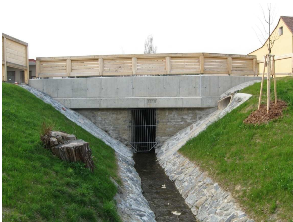
Obr.16. Ústí vodního tunelu v Radíkově
