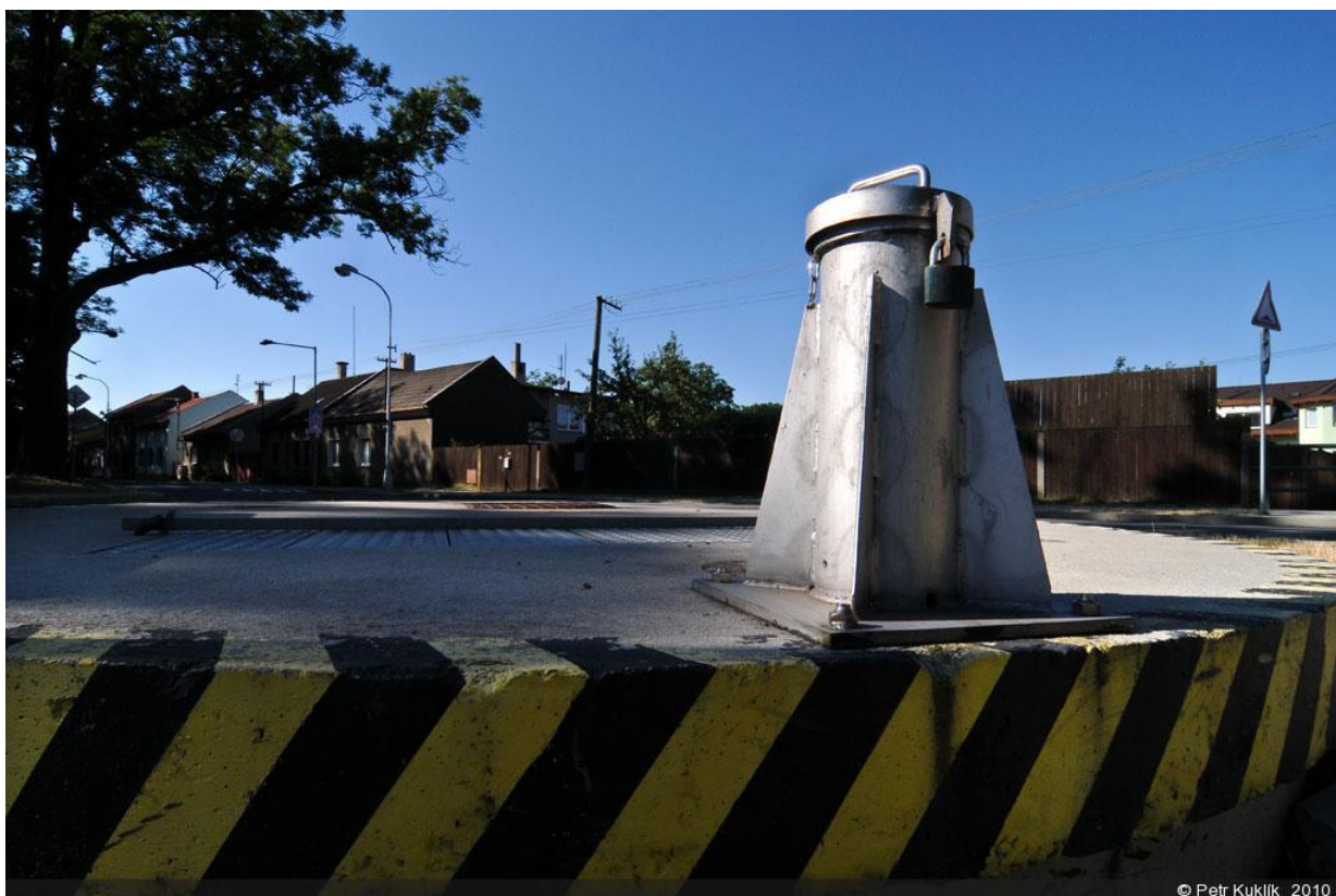
Obrázek 10 - Projekt Dobudování a rekonstrukce kanalizační sítě města Olomouc (Foto: Petr Kuklík, 2010)
