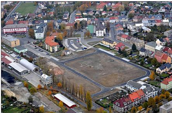
Obr. 21: Lokalita bývalých kasáren připravená k výstavbě polyfunkčních domů
