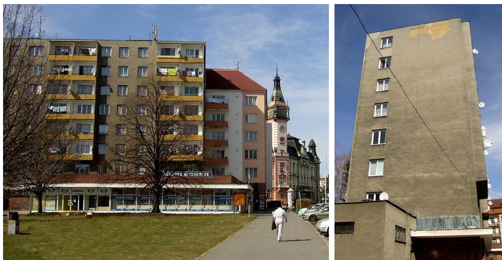
Obr. 15 a 16: Panelový dům na nám. Minoritů, čelní a boční pohled (foto: autor)
