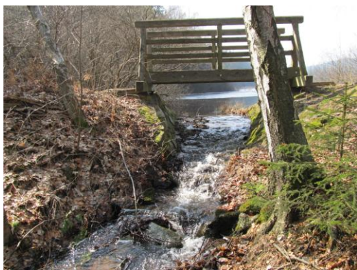
Obr. 12: Odtok vody do Řásenského potoka (foto: autor, 2012)
