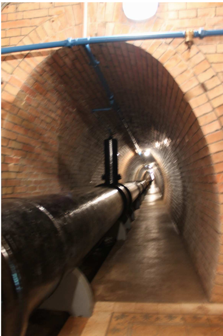
Obr. 9 Štola I. březovského vodovodu v Březově nad Svitavu 56
