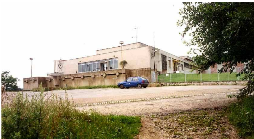
Obr. 8 Vodojem na Palackého vrchu 55
