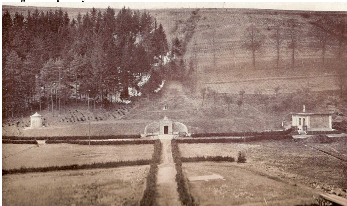
Obr. 3 Vchod do štol v Quellhütten 50
