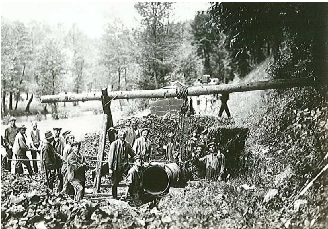
Obr. 7 Pokládání potrubí I. březovského vodovodu 54
