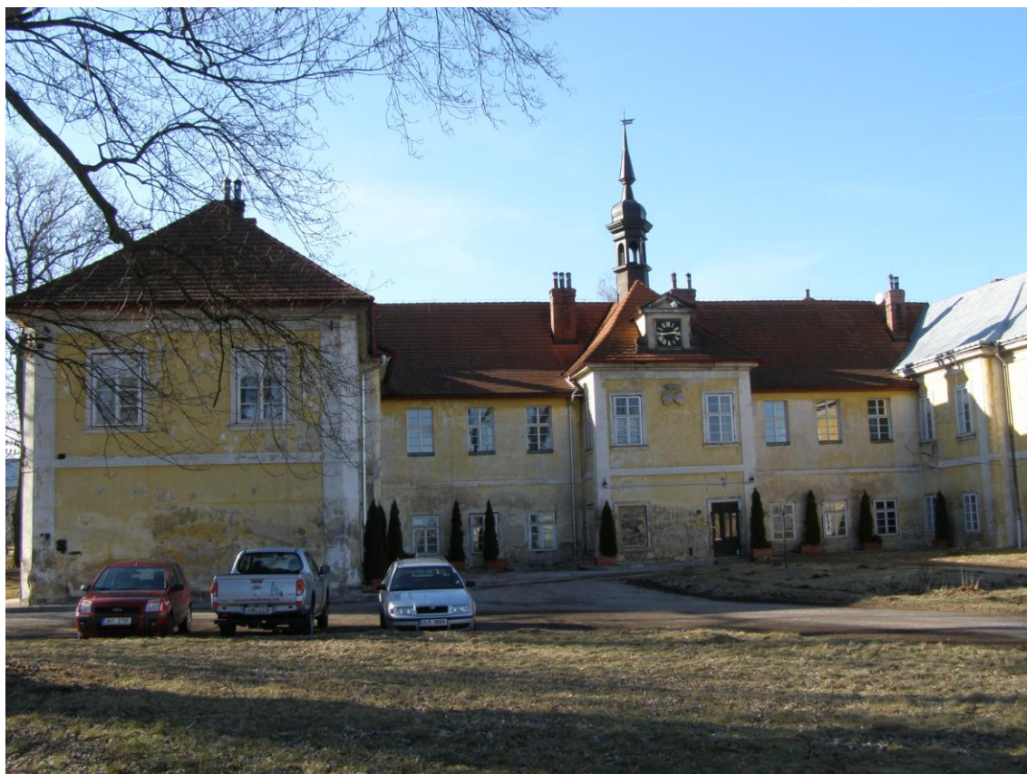
Obr. č. 10: Chátrající zámek ve Vokšicích (Podhradí), vlastní foto
