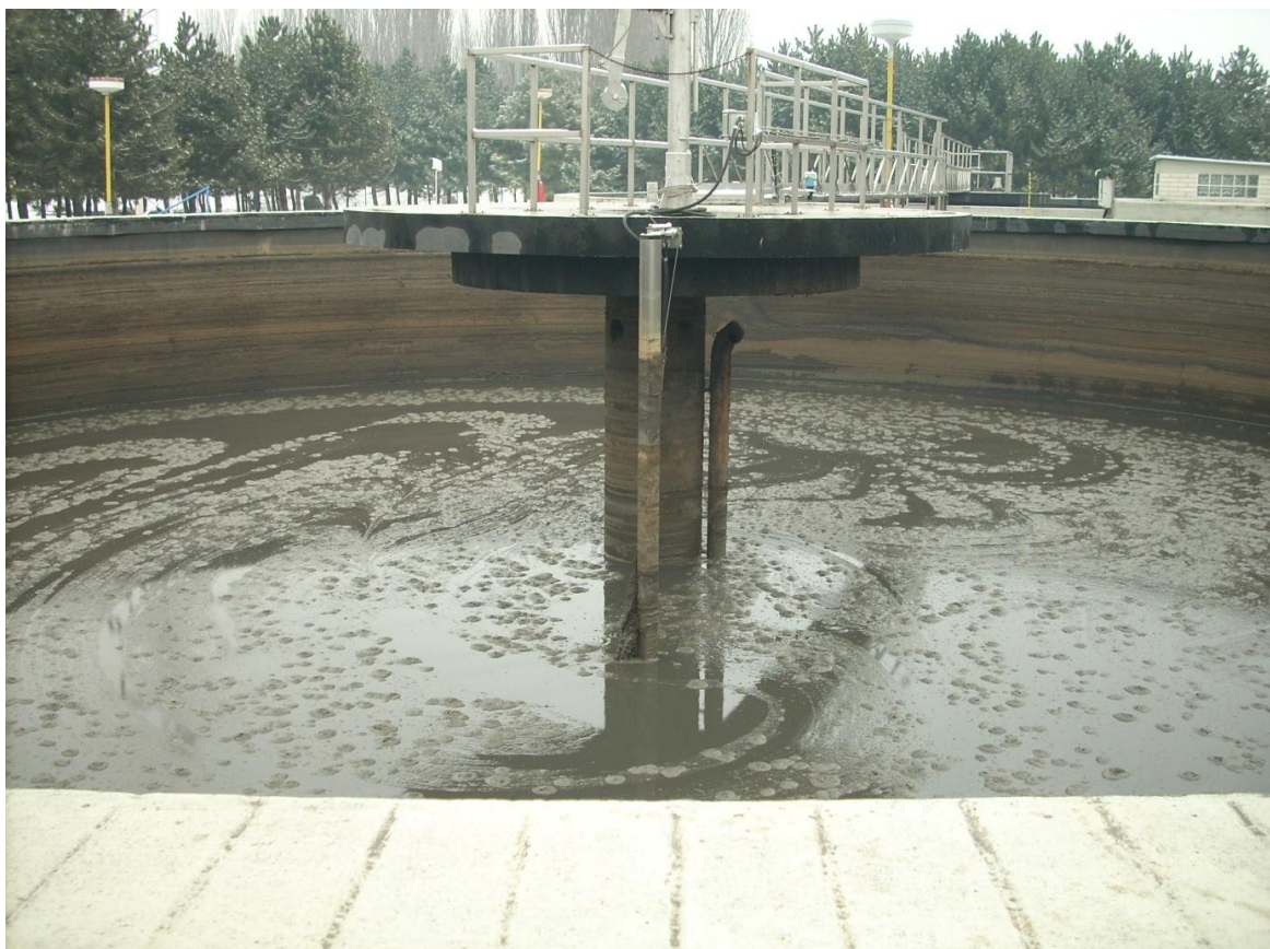
Obrázek 3 - Homogenizační nádrž kalu čistírny odpadních vod v Otrokovicích (foto: Veronika Slovácová, Otrokovice, 2. 3. 2012)
