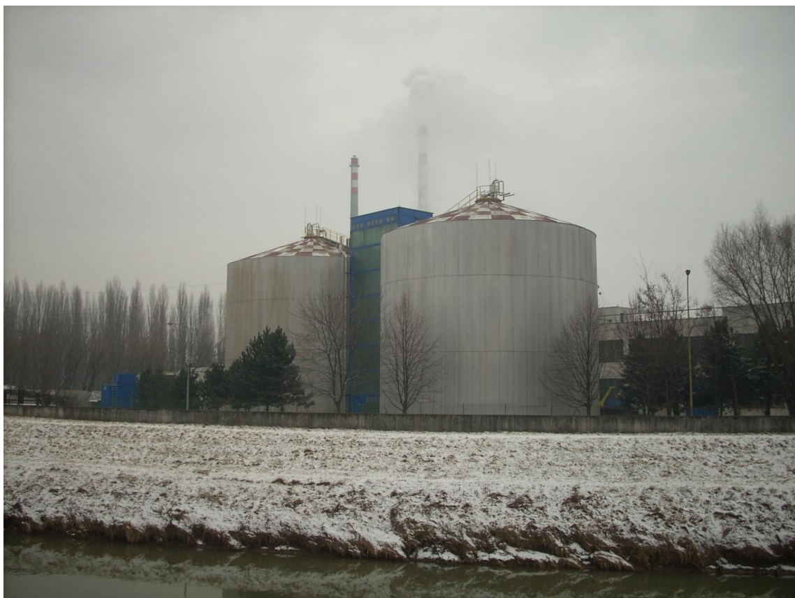
Obrázek 4 - Vyhňivací nádrže čistírny odpadních vod v Otrokovicích (foto: Veronika Slovákova, Otrokovice, 2. 3. 2012)
