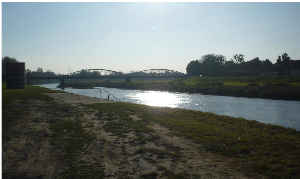
Foto č. 14: Hraniční most ve Starém Bohumíně (Skokanová, 9/2010)
