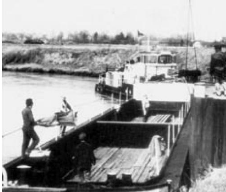
Obr. č. 25.a: Říční přístav na řece Odře z roku 1975 (zdroj: Společnost Poodří, 2006)
