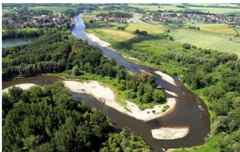
Obr. č. 2.a: Protržený meandr Odry v Bohumíně (zdroj: Spáčil, J. 2011)
