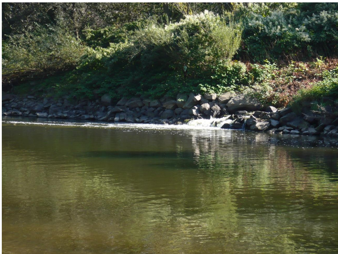
Foto č. 29: Zpevněný břeh kamením na vodním toku Odry (Skokanová, 10/2011)
