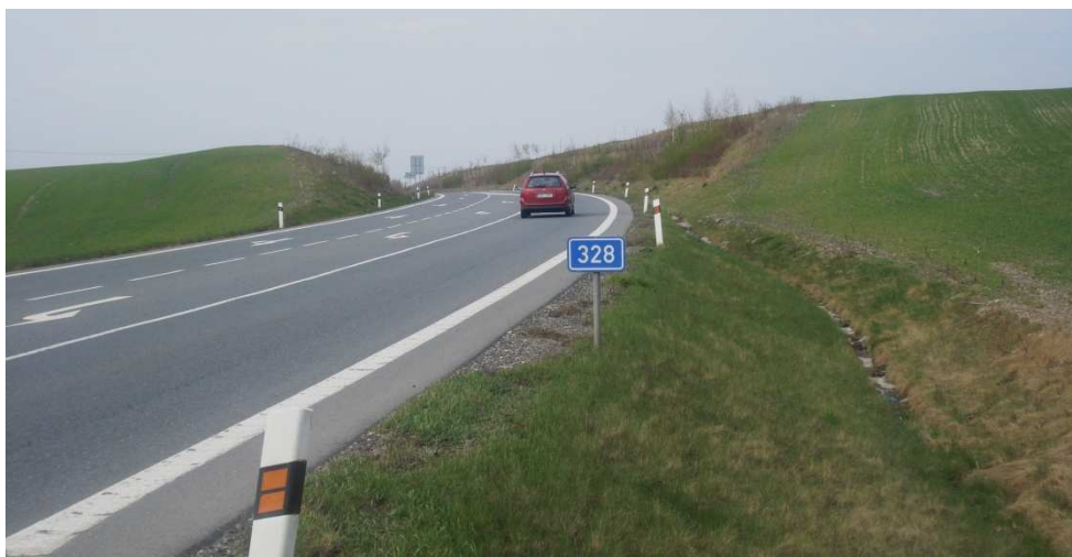
Obr. 10 Komunikační průkop na obchvatu Jestřabí Lhoty (Jiří Pospíšil, březen 2012)
