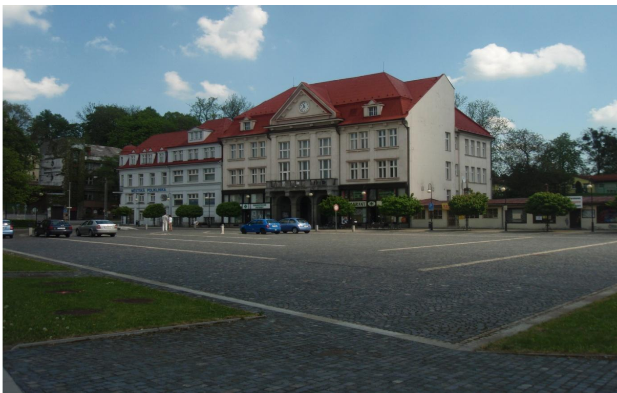
Obrázek 22: Orlovské náměstí po rekonstrukci. Vlastní sbírka.
