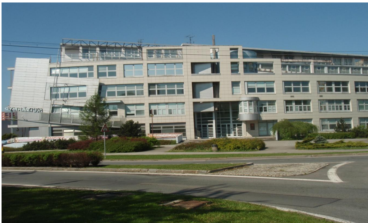
Obrázek 32: Budova Gymnázia a SOŠ. Vlastní sbírka.
