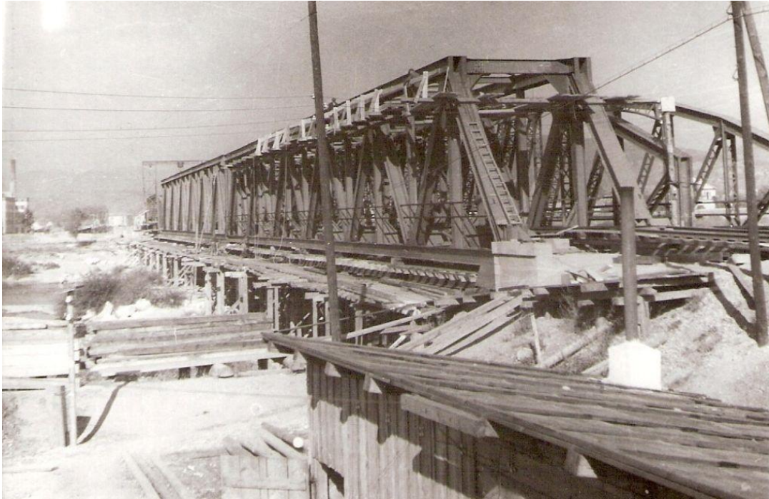
Obrázok 2c – Stavba mosta na prvej koľaji v roku 1947
