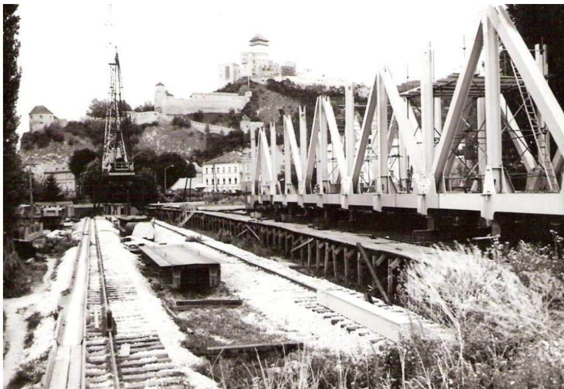
Obrázok 2e – Rekonštrukcia mostu v roku 1983
