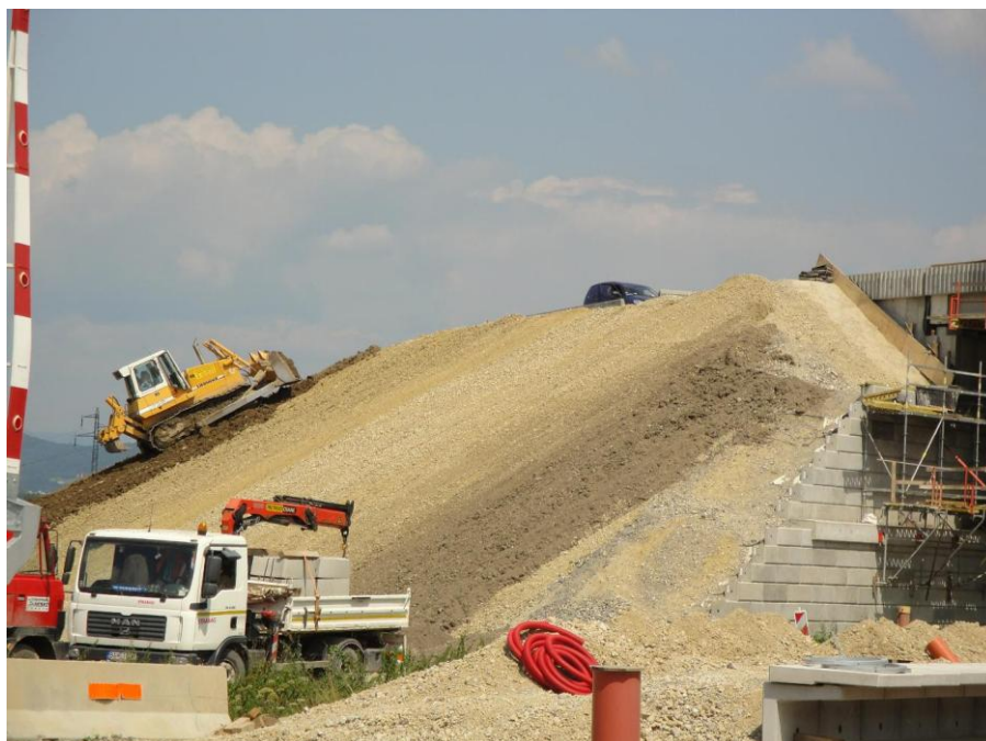
Obrázok č. 10 – Stavba dopravného násypu spojená s modernizáciou železničnej trate (Tomáš Mikulovský, 3. 8. 2011)
