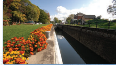
Plavební komora Vnorovy II.
