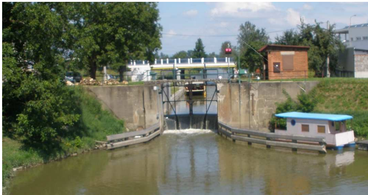
Obr. 21 Rejda u komory Staré Město - manipulační prostor pro přechod plavidel z běžné tratě vodní cesty do plavební komory (Sobota, 2003).
