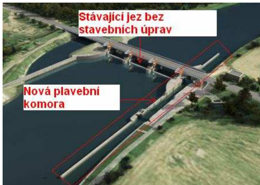
Obr. 16 Vizualizace komory u jezu Bělov na pravém břehu řeky (www.rvccr.cz)
