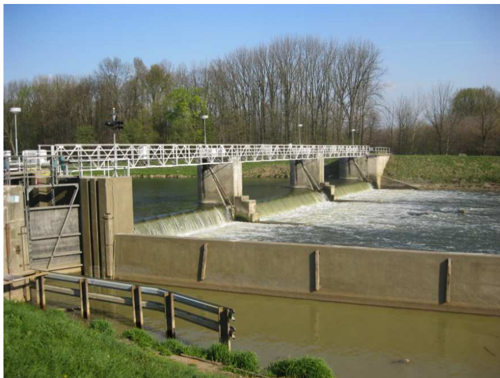
Obr. 26 Jez Kunovský les, u jezu plavební komora (foto P. Hubáčková 15.4.2011)
