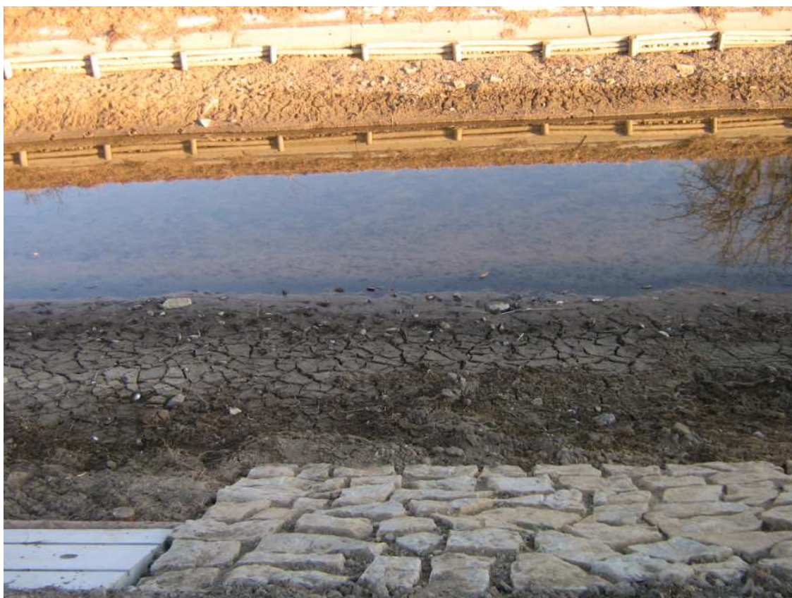
H) Ukázka kamenné a betonové dlažby (na protějším břehu) na kanále na trati Babice-Spytihněv (foto P. Hubáčková 8.3.2011)
