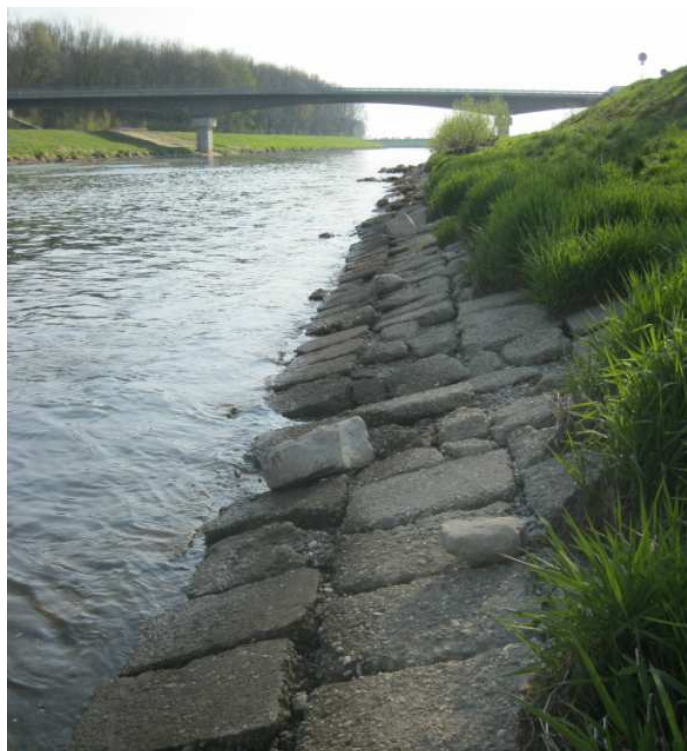
G) Ukázka betonové dlažby na pravém břehu řeky Moravy pod jezem Kunovský les (foto P. Hubáčková 15.4.2011)
