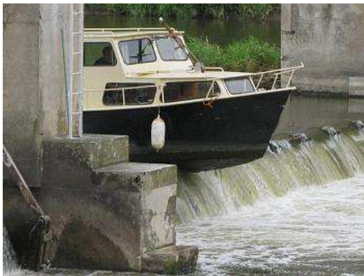
Obr. 18 Loď přešla hranu jezu a zůstala na ní stát s přední částí ve vzduchu.
