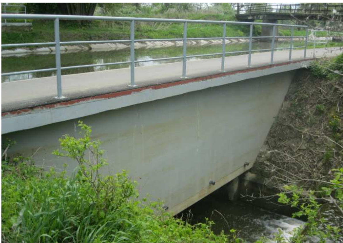
Obr. 31 Průplavní most přes potok Vrbka. (foto P. Hubáčková 30.4.2011)
