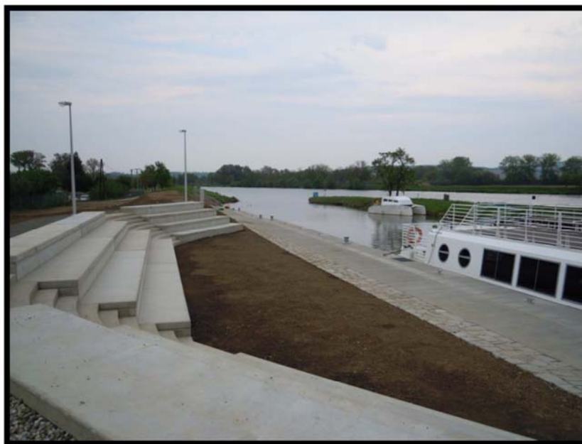
Obrázek č. 18: Přístaviště s nově vybudovaným amfiteátre u Bařova kanálu v obci Spytihněv
