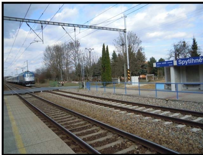
Obrázek č. 15: Železniční zastávka v obci Spytihněv
