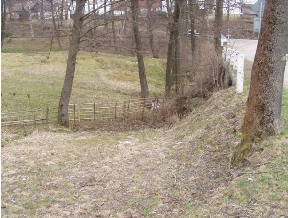
Obr. f7.: Hráz tvořena silnicí, jejíž koruna dosahovala 2 metrů, výška 6 m a délka 90 m.
