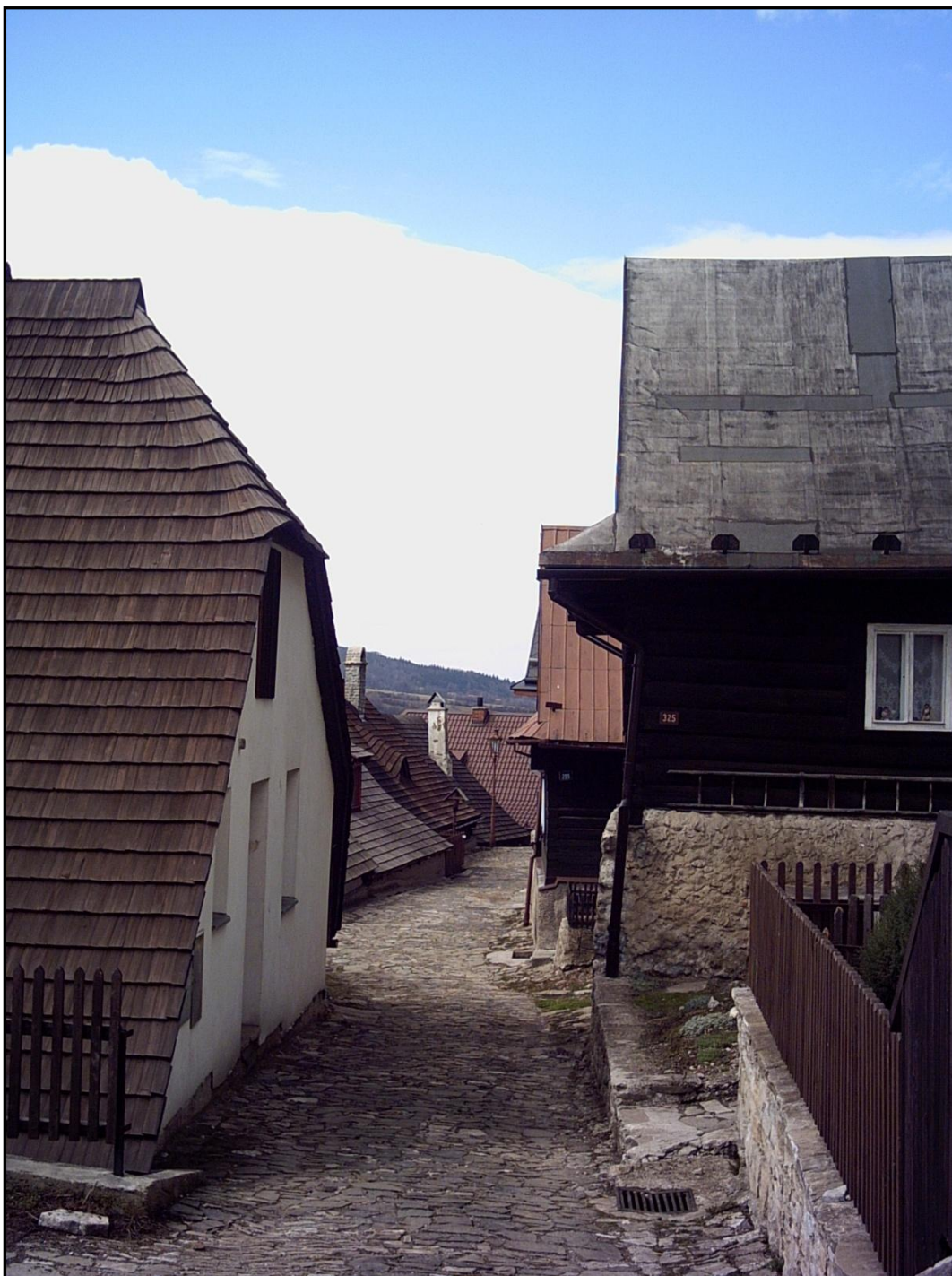
Obr. 3: Venkovské usedlosti v Horní Baště
