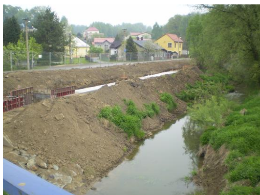
Obr. 27 : Průběh výstavby betonové stěny na 9,938 ř. km v dubnu 2011 (foto: Szczyielová, E., 2011)
