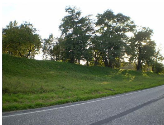
Obr. 7: Pravý val železničního průkopu (foto: Szczygielová, E., 2010)
