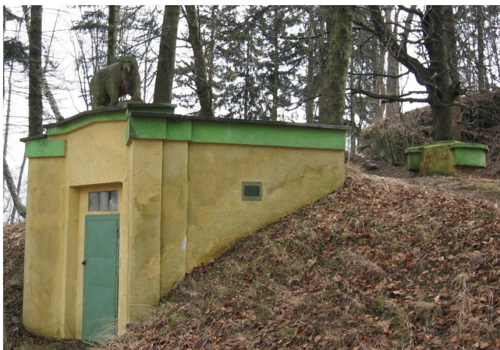
Obr. 6: Historický vodojem (foto: D. Štěpánková, 2011)
