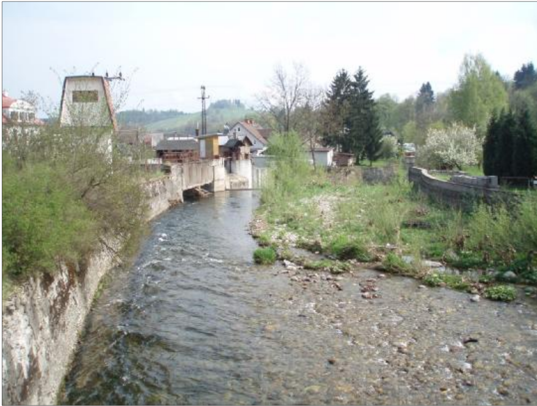
Obr. 22: Jímací objekt k MVE Texlen Lena 57, 030 (Zdroj: Eva Součková, 25. 4. 2011)
