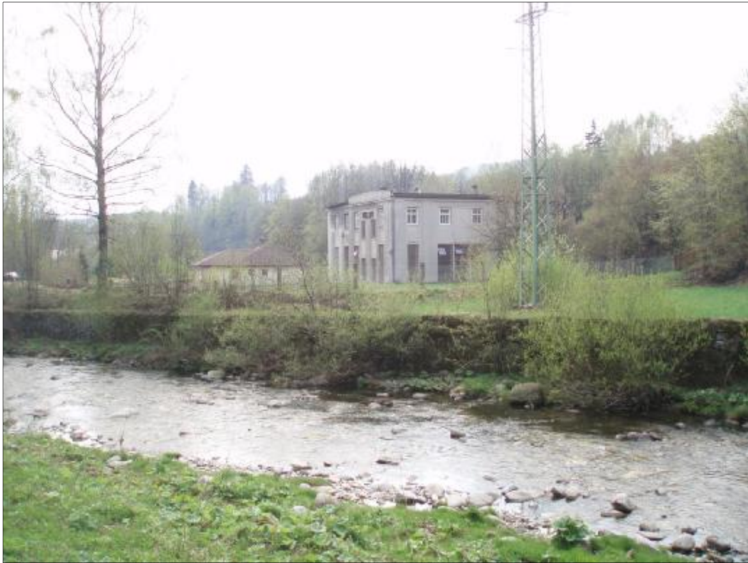
Obr. 28: Budova strojovny MVE 63, 143 Horní Maršov Genova s.r.o. (Zdroj: Eva Součková, 25. 4. 2011)
