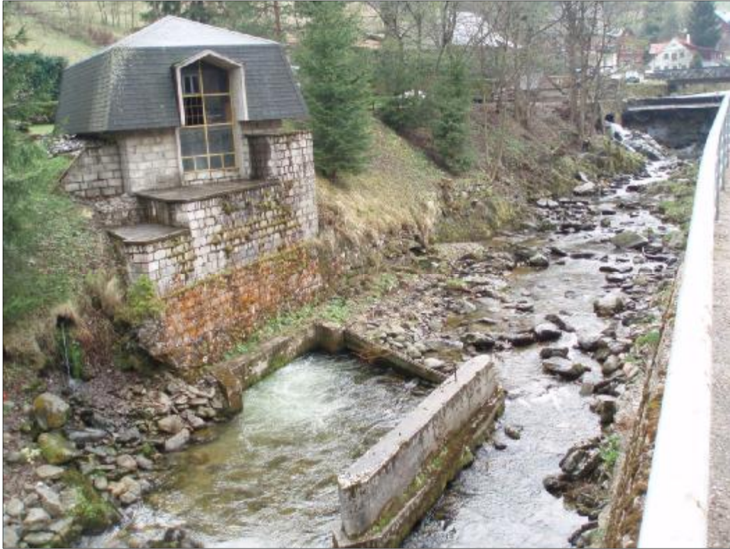
Obr. 36: MVE Velká Úpa 70, 850 Sochor Strojovna, zadržovací objekt a jímání (Zdroj: Eva Součková, 25. 4. 2011)
