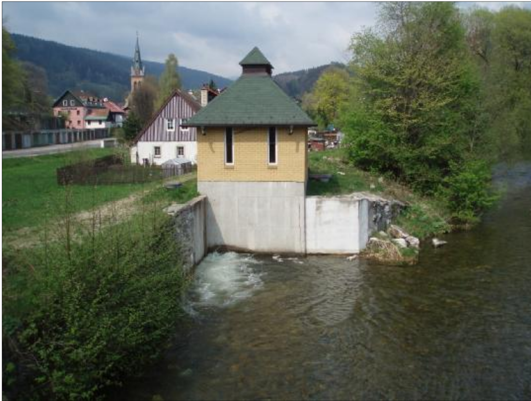
Obr. 30: Fungující strojovna MVE 63, 910 Energo Plus s.r.o. (Zdroj: Eva Součková, 25. 4. 2011)
