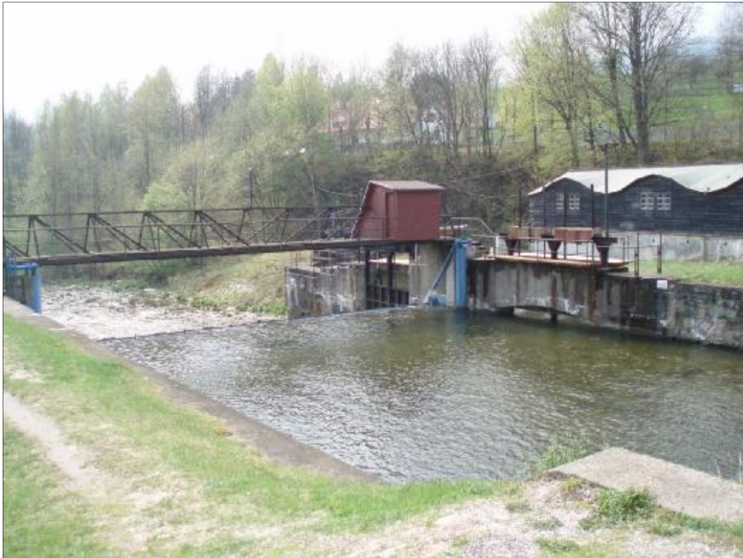
Obr. 26: Jímací objekt MVE 63, 143 Horní Maršov Genova s.r.o. (Zdroj: Eva Součková, 25. 4. 2011)
