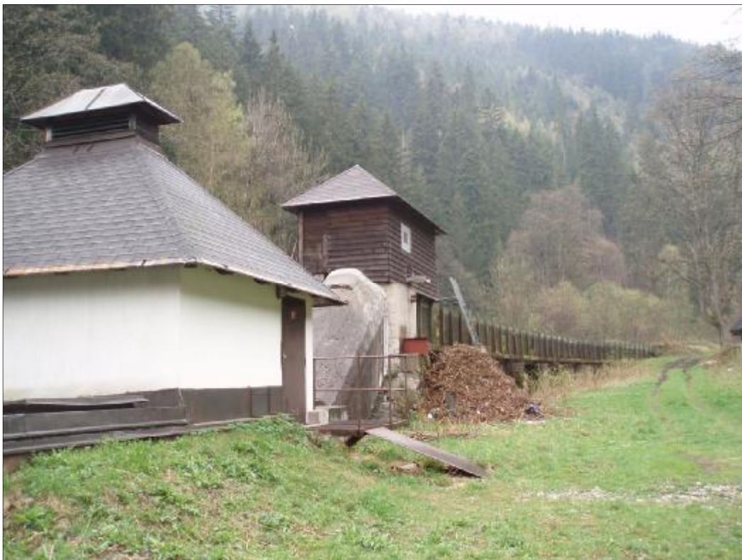
Obr. 33: Strojovna a náhon MVE Mechanika 66, 356 (Zdroj: Eva Součková, 25. 4. 2011)
