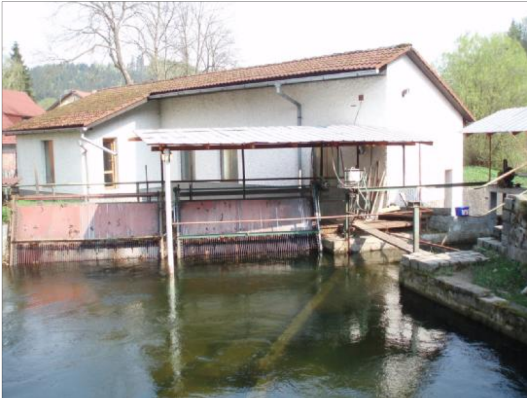
Obr. 17: MVE 54, 002 Kos Čištění před turbínami (Zdroj: Eva Součková, 25. 4. 2011)
