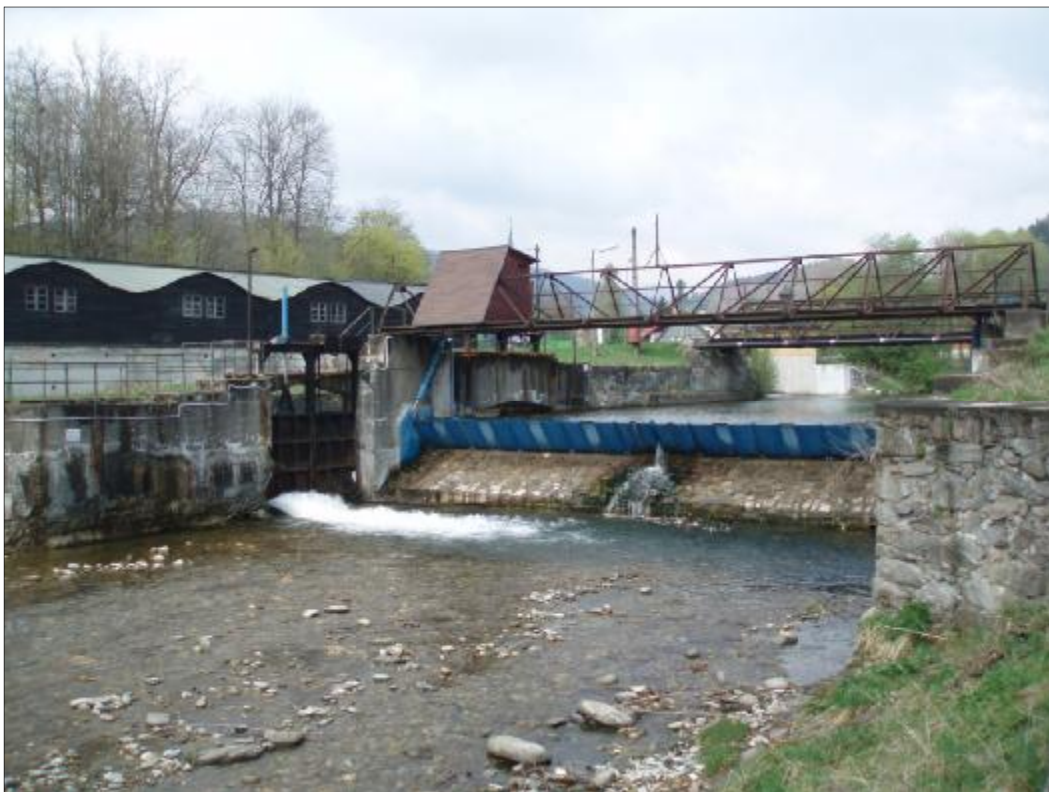
Obr. 27: Zadržovací objekt a jímání MVE 63, 143 Horní Maršov Genova s.r.o. (Zdroj: Eva Součková, 25. 4. 2011)
