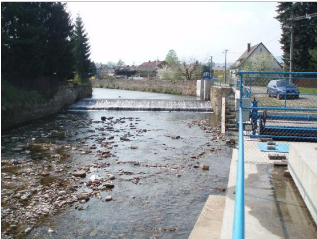
Obr. 20: MVE 55, 438 Havran Zadržovací objekt a rybí přechod (Zdroj: Eva Součková, 25. 4. 2011)
