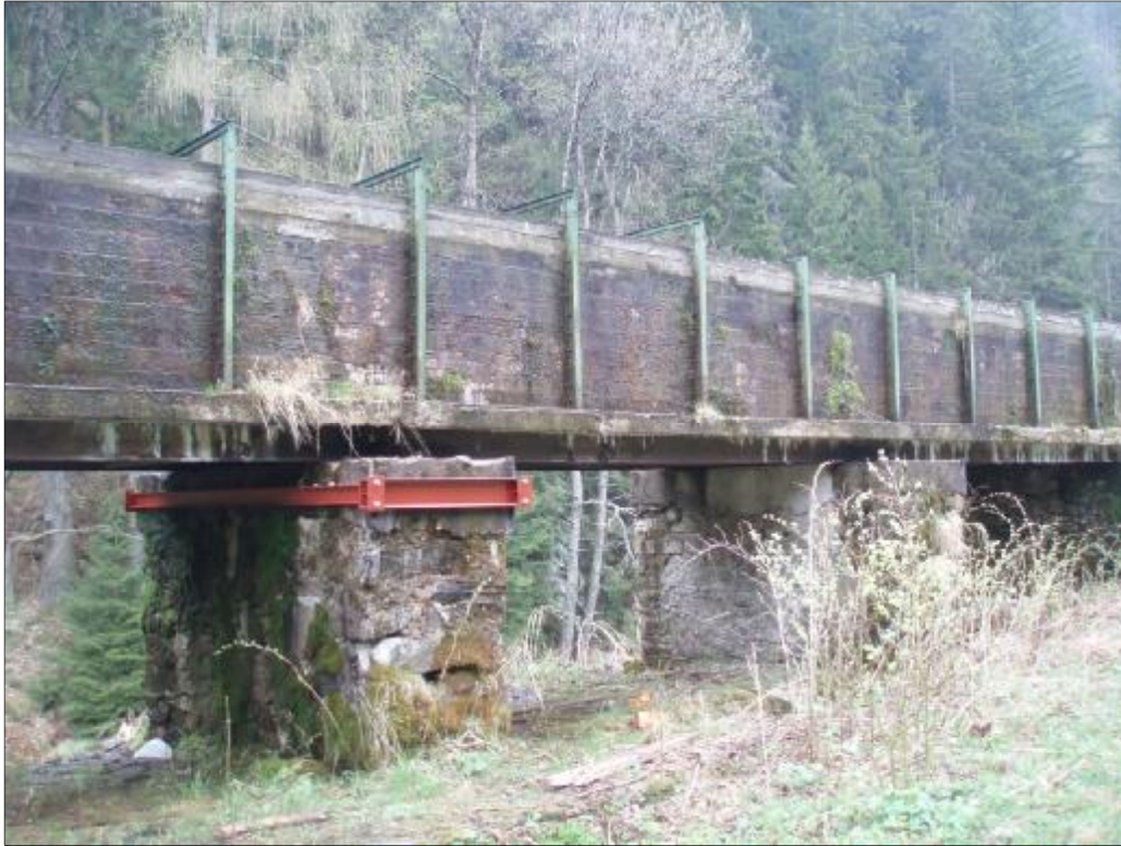
Obr. 34: Vzdušný náhon MVE Mechanika (Zdroj: Eva Součková, 25. 4. 2011)
