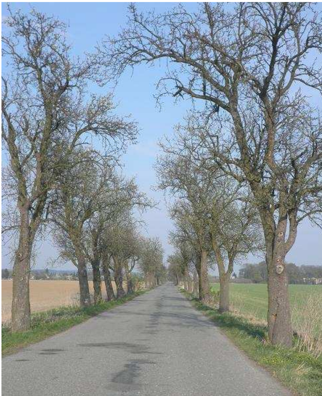
Obr.30. Alej Citov – Věrovany, čelní pohled od mostu přes řeku Moravu (foto Petr Novák 19.4.2011)
