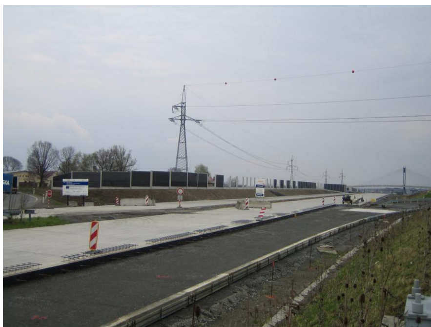
Obr. 13: Průběh stavby dálnice D1 (D47) v úseku Bohumín – státní hranice ČR/PL (zdroj: Fojtík, 2011)
