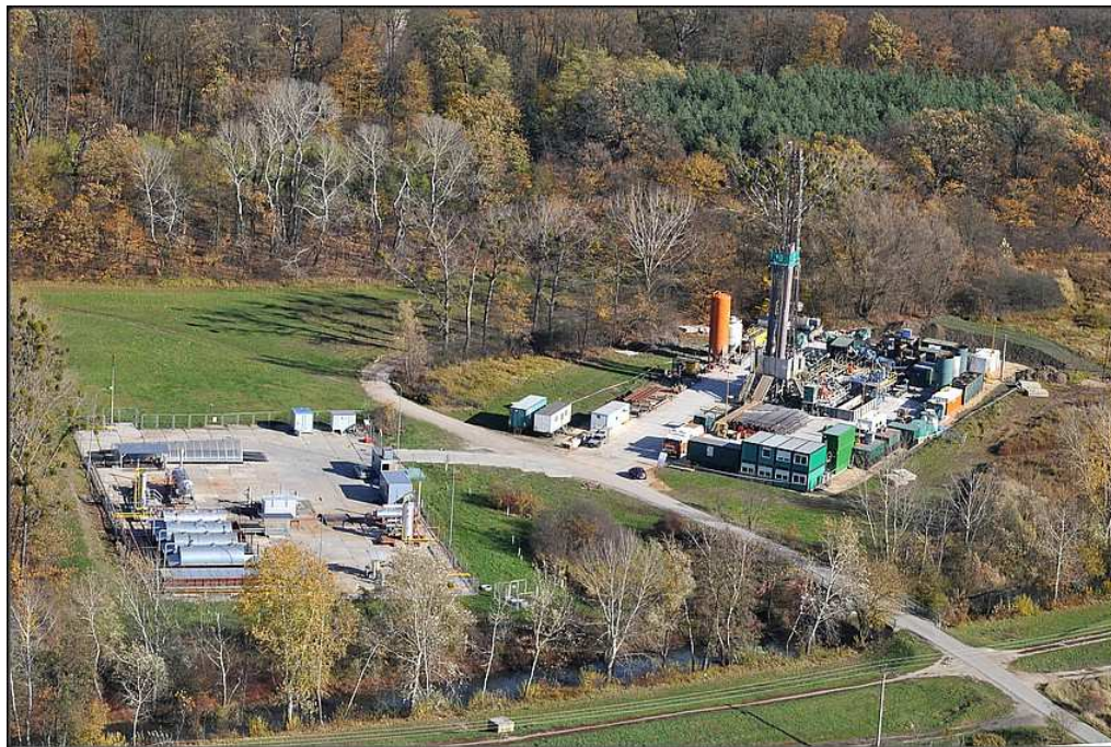
Obr. č. 15: Těžební středisko ropy Poštorná-1 společnosti ČNS a vrtná souprava IDECO DIR 806 při hloubení vrtu Poštorná-10 pro stejnou společnost ( říjen 2008, foto poskytl ČNS)
