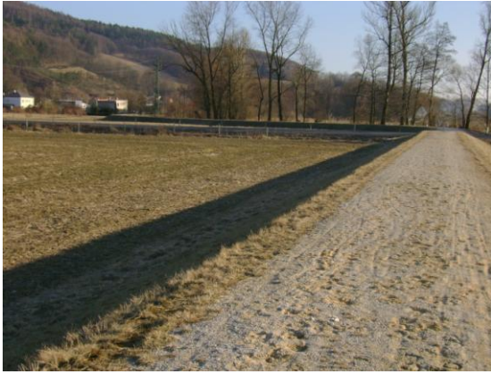
Foto 31 Protipovodňová hráz u Lesnice (Drtilová, 3/2011)
