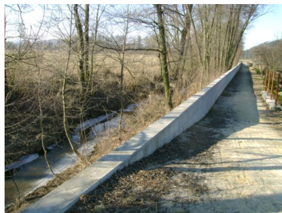
Foto 22 Betonová protipovodňová hráz za Lesnicí (Drtilová, 3/2011)
