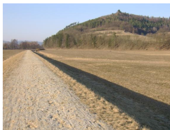
Foto 30 Protipovodňová hráz u Lesnice (Drtilová, 3/2011)
