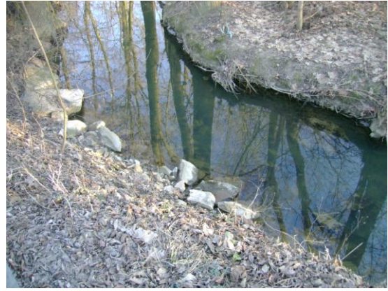
Foto 8 Zpevněné břehy na Loučce (Drtilová, 3/2011)
