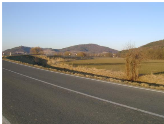
Foto 28 Protipovodňová hráz = silnice mezi Leštinou a Lesnicí (Drtilová, 3/2011)
