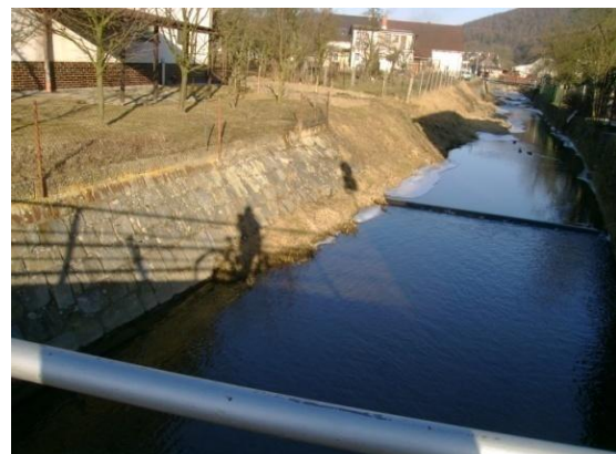
Obr. 11 Kamenné zpevnění na Loučce v Lesnici (Drtilová, 3/2011)
