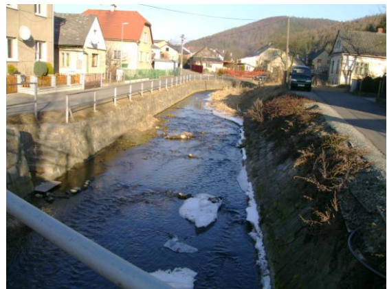
Foto 10 Koryto Loučky vydlážděné kamennou dlažbou v Lesnici (Drtilová, 3/2011)
