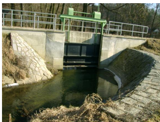
Foto 23 Nové stavidlo v protipovodňové hrázi u Lesnice (Drtilová, 3/2011)
