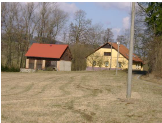
Foto 5 Bývalý mlýn v Brníčku (Drtilová, 3/2011)
