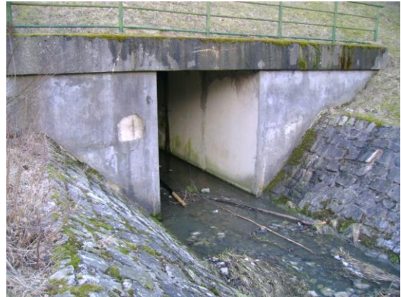
Foto 2 Vyústění potoka ze závlahové nádrže v Hrabšíně (Drtilová, 3/2011)
