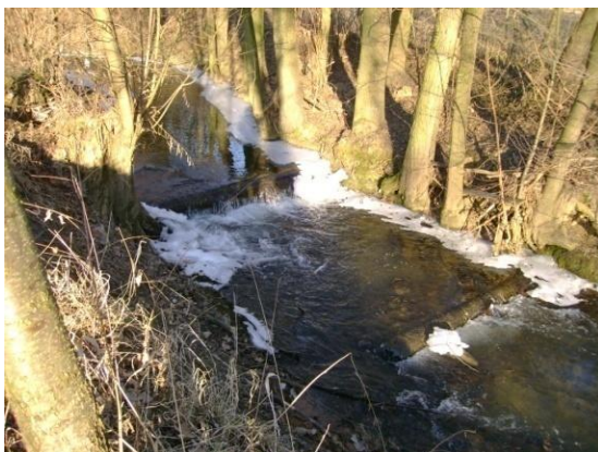
Obr. 10 Příčné zpevnění koryta Loučky (Drtilová, 3/2011)
