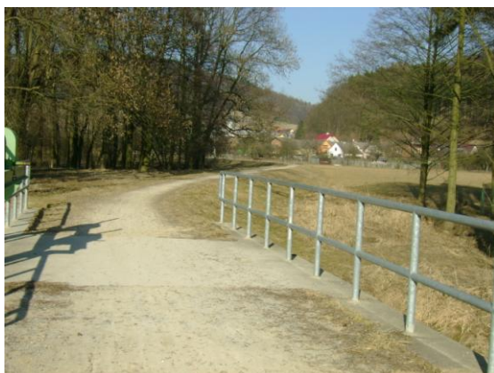
Foto 27 Protipovodňová hráz v Lesnici (Drtilová, 3/2011)
