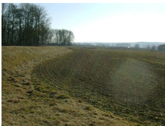
Foto 29 Protipovodňová hráz u Lesnice (Drtilová, 3/2011)
