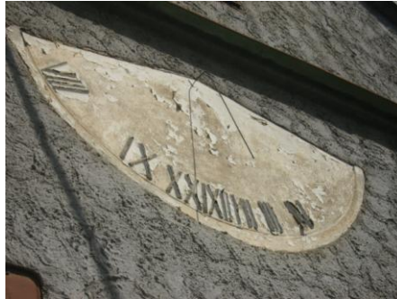
Obr. 32: Hodiny jsou umístěny na boční straně domu (Hana Savčáková, 2011)
