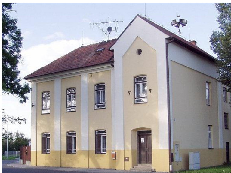
Obr. 3: Stav budovy od roku 2006, kdy došlo k odstranění ukazatele (zdroj: http://astro.mff.cuni.cz , Jana Nečasová, 2006)
