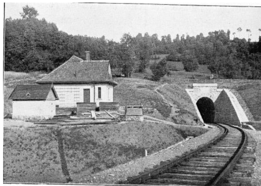
Obr. 7: Strážní domek u Návojenického tunelu
