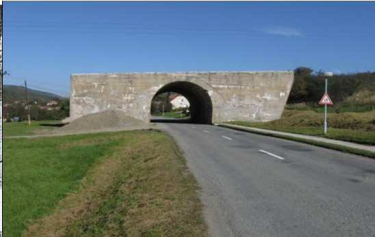
Obr. 14: Nedokončený dálniční most v Ludkovicích (zdroj: www.davar.cz )
