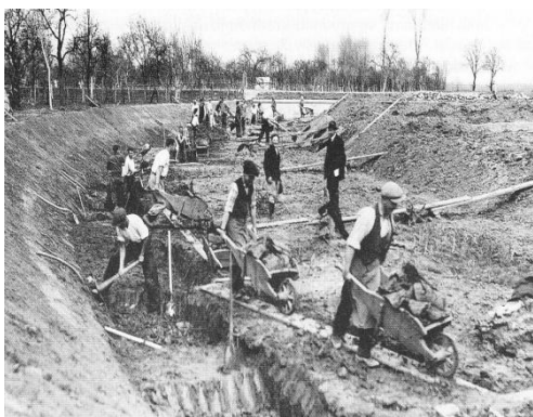
Obr. 8: Práce na korytě kanálu u Spytihněvi, 1935
