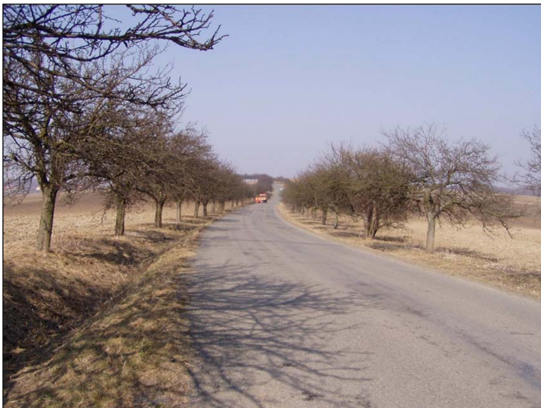
Obr. 13 Provádění údržby na aleji u Němetic (foto Jan Česnek 11. 3. 2011)
