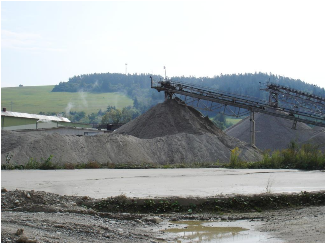
Obr.6.: Pásový dopravník, v popredí odkalisko, Malá Bytča (Foto: M. Pramuková, 16.9.2009)
