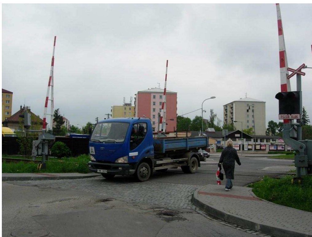
Obr. 17: Přejezd „P 6544“ na trati 271: Prostějov – Chornice (autor fotografie: Radek Poledníček)
