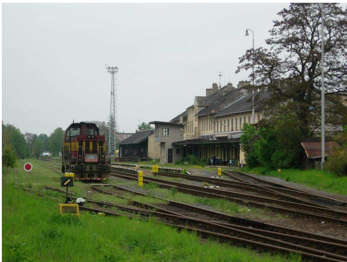
Obr. 20: Železniční stanice Prostějov místní nádraží (autor fotografie: Radek Poledníček)
