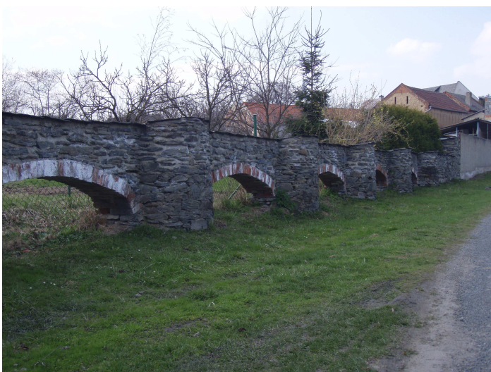
Obr. 13: Protipovodňové vally v Seničce (autor: Tomáš KÖRNER)
