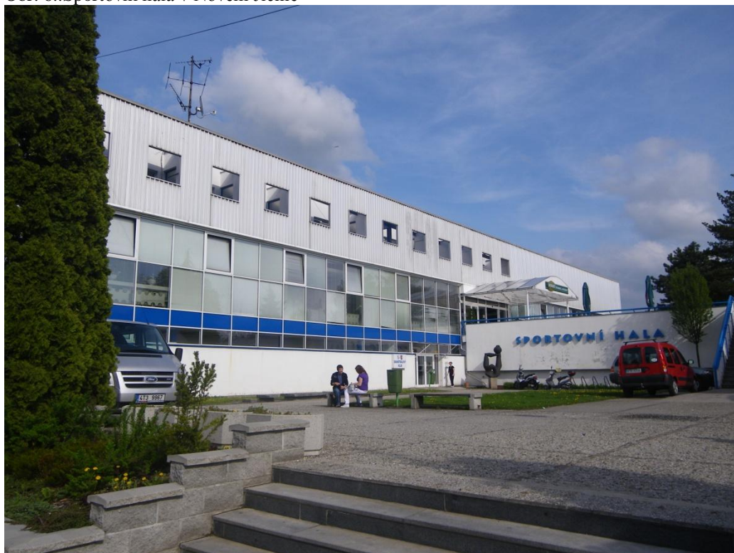
Obr. 6.: Sportovní hala v Novém Jičíně
