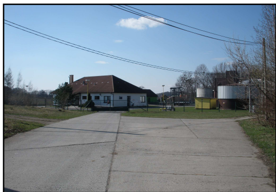
Obrázek 22 – Příjezdová cesta do ČOV v Rychlově Foto: L. Hradilíková, 03/2010
