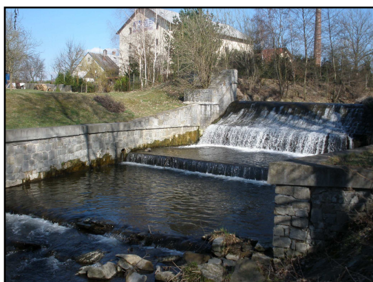
Obrázek 20 – Kamenný jez poblíž ČOV v místní části Rychlov u Bystřice p.Host.
