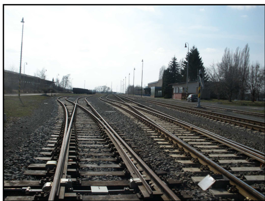
Obrázek 10 – Železniční výhlaz ve stanici Bystřice pod Hostýnem
