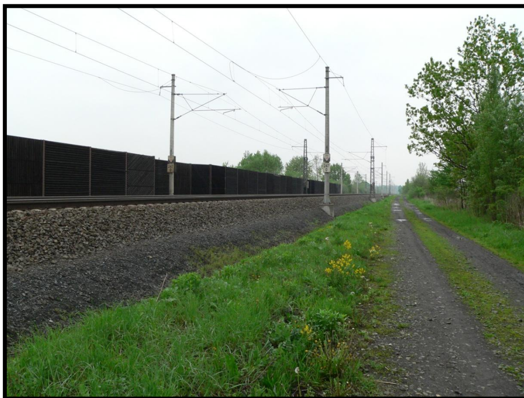
Foto 20: Železniční násep trati Přerov-Ostrava (R.Doležalová, 20. 4. 2010)
