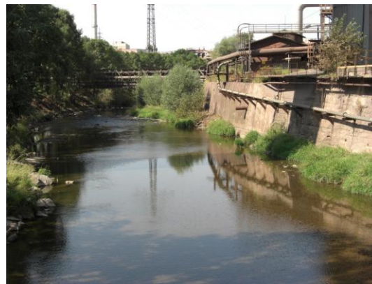
Obr. 13 Regulované koryto řeky Olše
