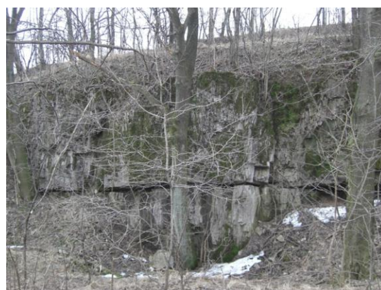
Obr. 4 Stěnový lom v lokalitě Na Horce v Kojkovicích v současnosti
