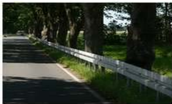
Obr. 20 Instalace svodidel v úseku aleje ( http://www.stromy.arnika.org )
