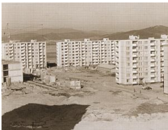
Obr 11: Výstavba sídliště na ulici Křížkovského Zdroj: Zábřeh – 750 let
