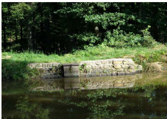
Obr. 20: Hráz na přítoku Netřeby (foto: T. Slezák, 7. 8. 2008)
