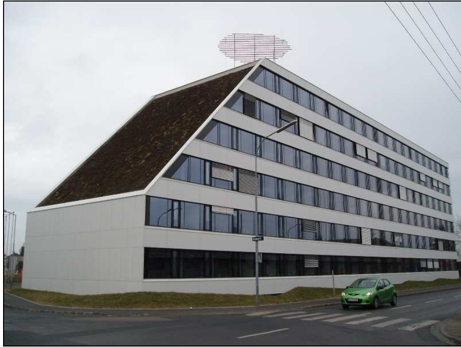
Obrázek č. 3.1 : Budova v níž sídlí Kärntner Institut für Seenforschung (KIS), Klagenfurt, (O. Sklenář, 2009)
