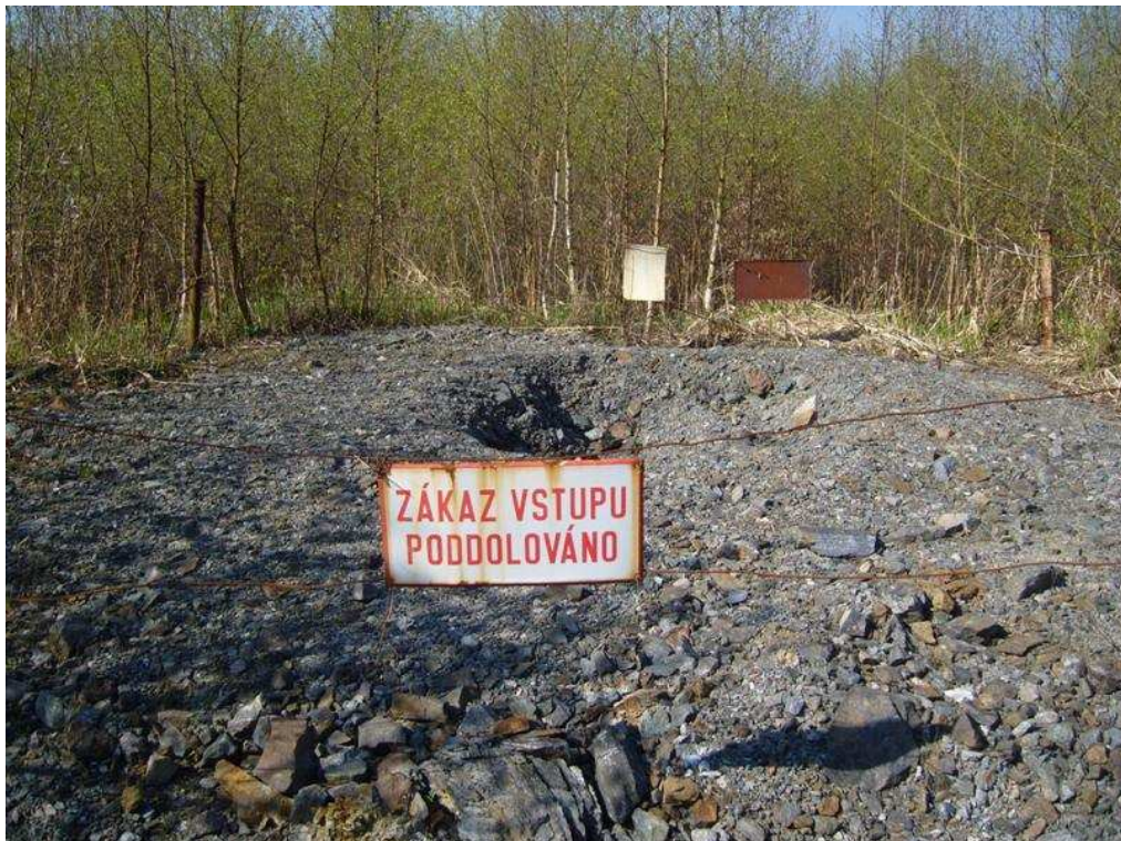
Likvidované důlní dílo zavezením (průzkumná jáma č. 35)
