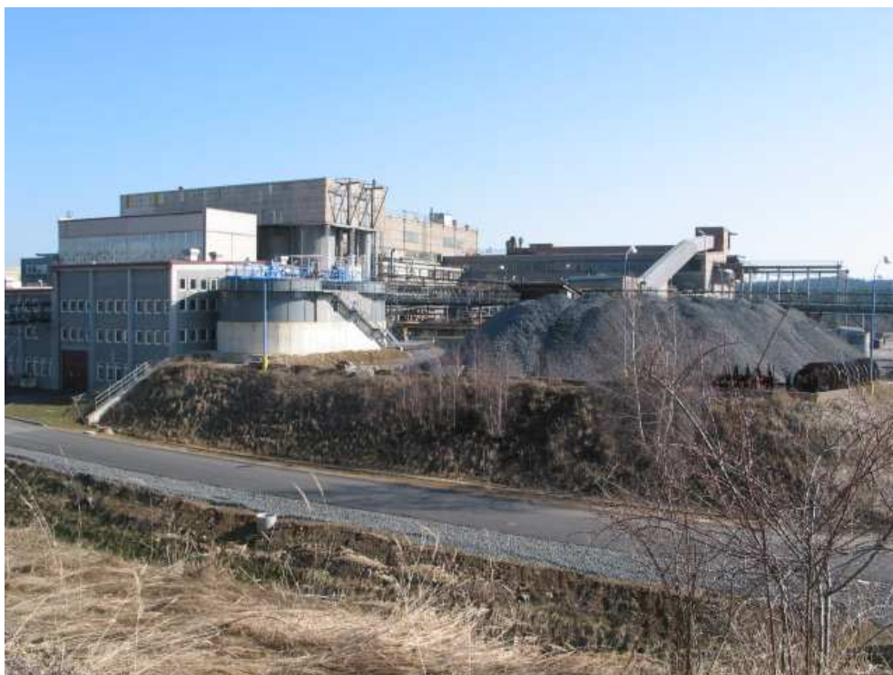
Areál Chemické úpravny - v popředí depo uranové rudy a nová budova čištění nadbilančních vod
