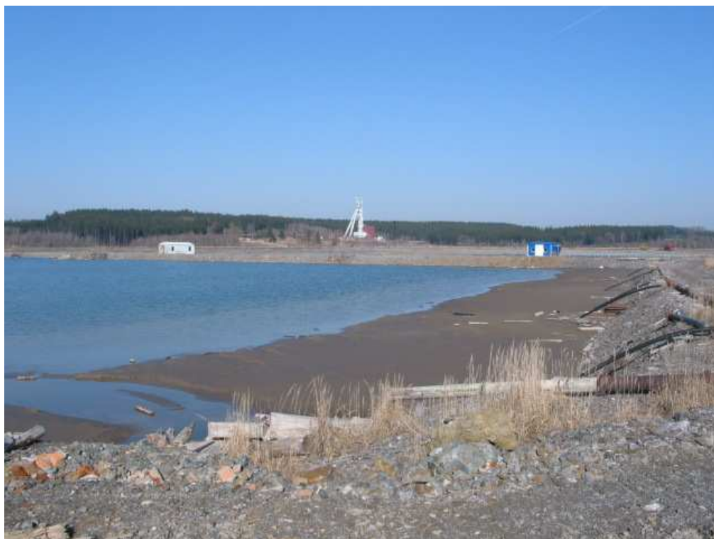
Odkaliště K 1 - v popředí vyplavený rmut, v pozadí těžní věž jámy Rožná 3
