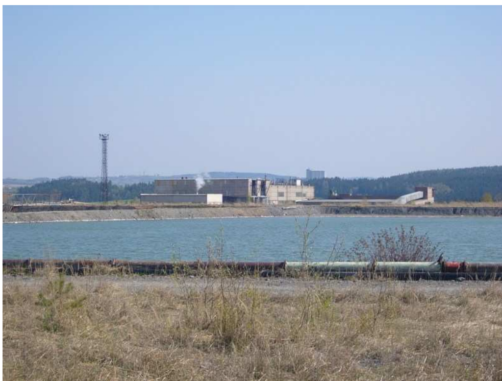
Pohled na chemickou úpravnu přes hladinu odkaliště K 1
