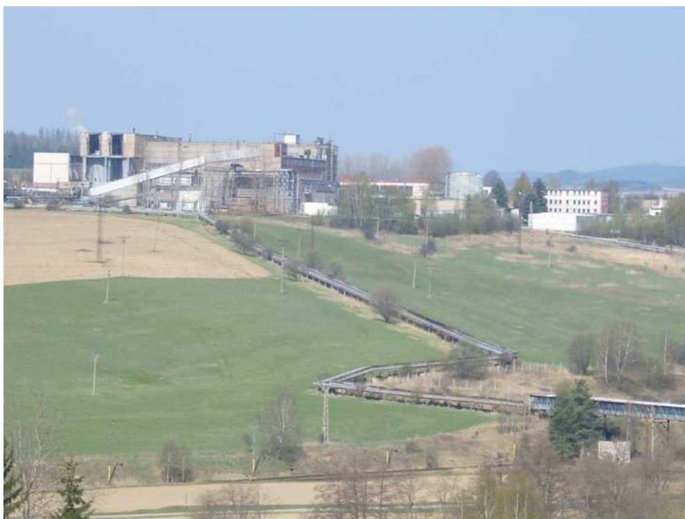
Pohled na areál Chemické úpravy od obce Rožná
