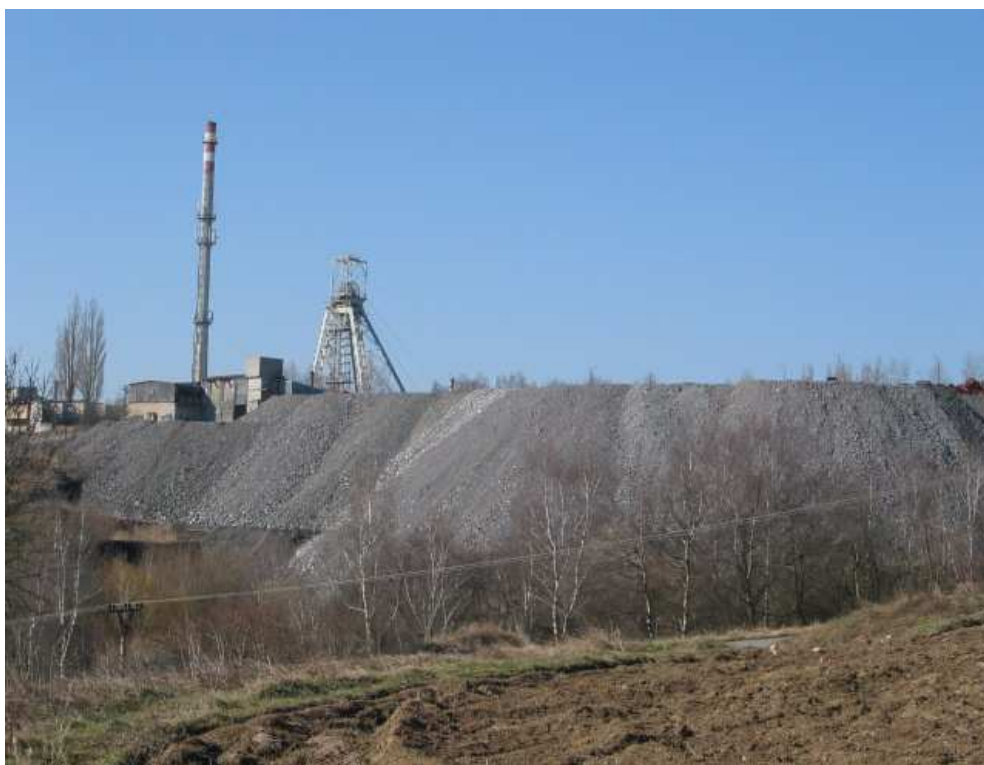
Závod Rožná I - těžní věž jámy Rožná 1, v popředí odval hlušinového materiálu (foto: Ing. Jiří Němec, 3. 4. 2009)
