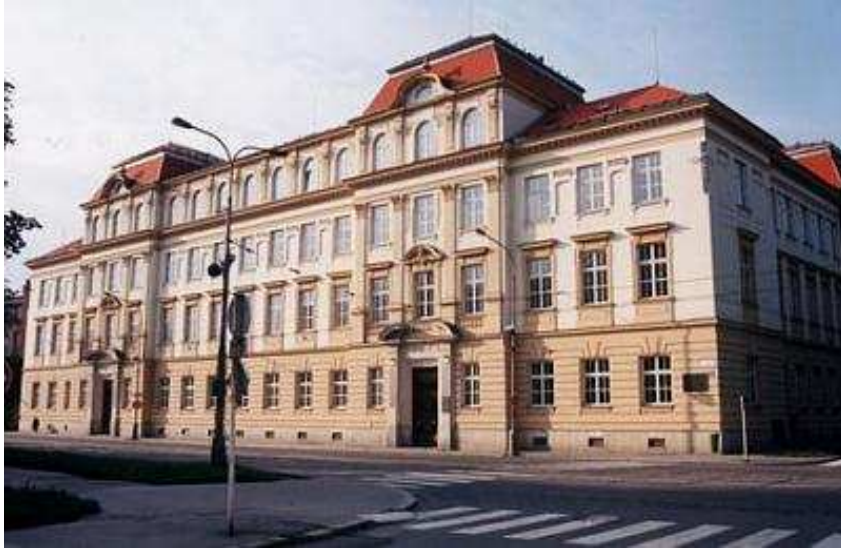
Obr. 2: Hlavní budova Přírodovědecké fakulty UP na tř. Svobody 26 [11]
